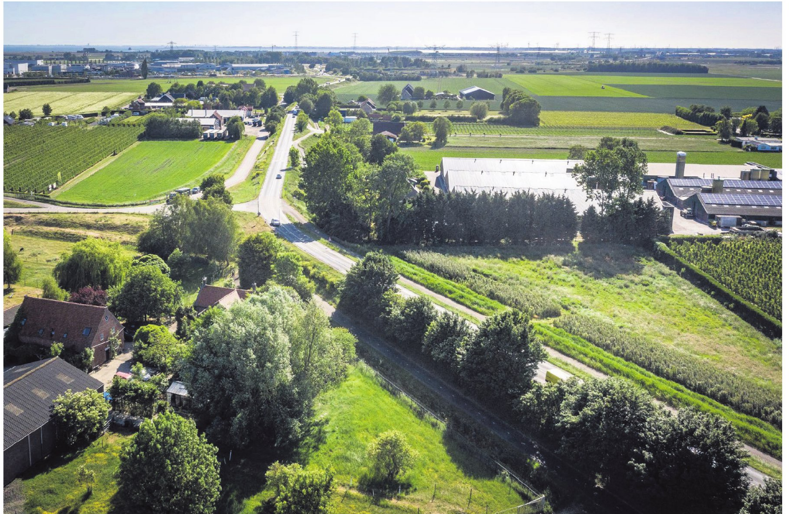
▲ Op de plaats de Zanddijk overgaat in de Molendijk, bij de kruising, ligt straks een nieuwe afslag naar bedrijventerrein Olzendepolder. De grond, het huis en de schuren links op de voorgrond zijn inmiddels door de provincie aangekocht. FOTO MARCELLE DAVIDSE
